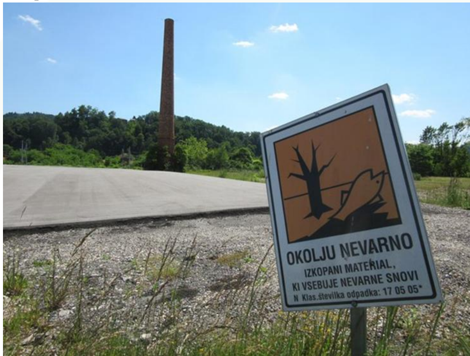
Slika 17: Območje Stare cinkarne v Celju, deloma remediirano, deloma pa še vedno vsebuje material, ki vsebuje nevarne snovi – izkopani so odpadki 17 05 05* (vir: ZAG)
